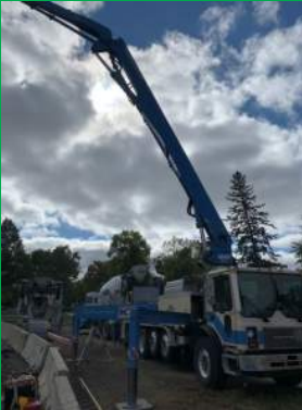
First Foundation Wall Pour
